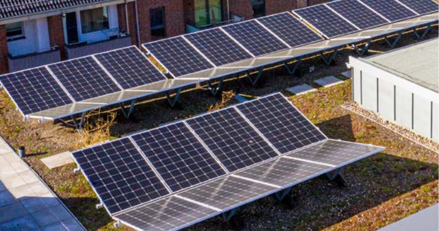
Auf dem Dach unseres Neubaus Hammer Baum gibt es bereits eine Photovoltaik-Anlage. Jetzt wird Solarstrom Pflicht.
